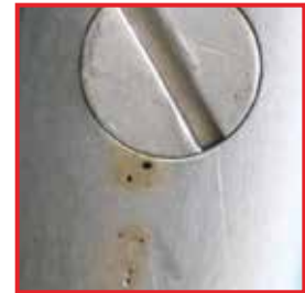
Ejemplo de corrosión de picadura
